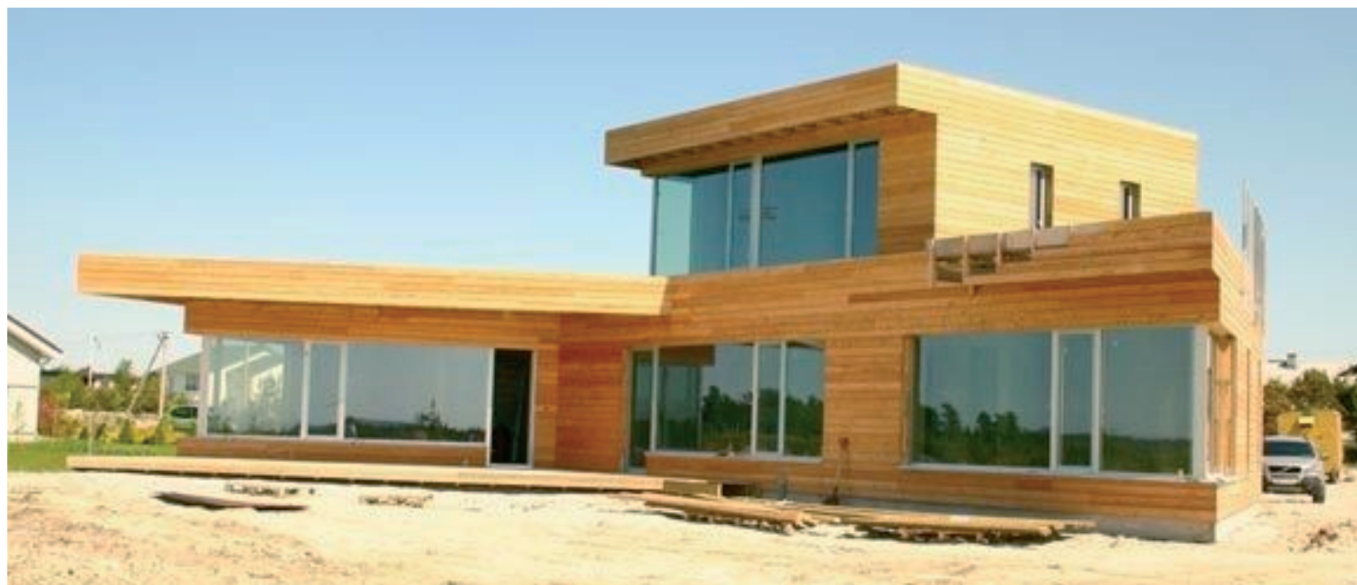
Рис. 20. Фото реализации плоской кровельной системы при строительстве каркасного дома.
