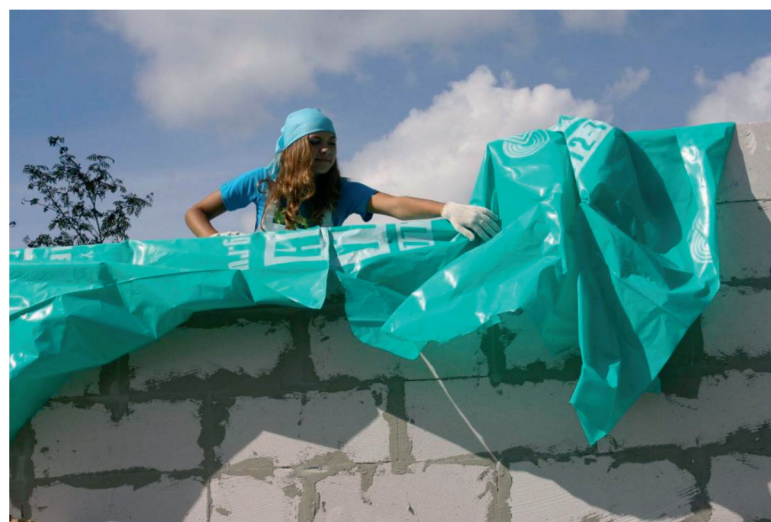
Рис.9. Защита от увлажнения облегченных блоков при внешнем утеплении, зимней консервации или на период просушивания.
