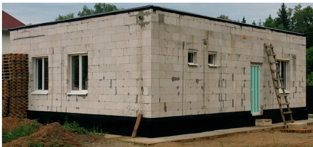
Рис.27 Фото реализации плоской кровельной системы при строительстве дома из облегченных блоков.
